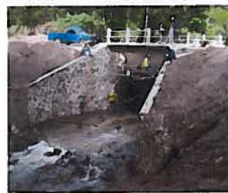
Ampliación y reparación de bóveda ubicada en estación 4+347
